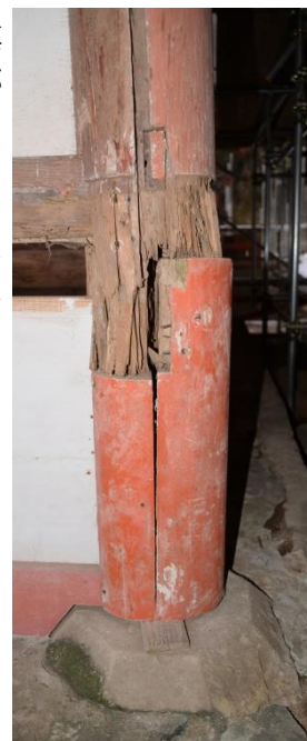
図 3 柱破損状況
