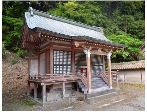
図 1 修理前南西面
