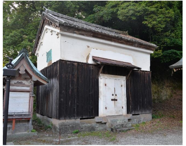
図1 修理前南東面
