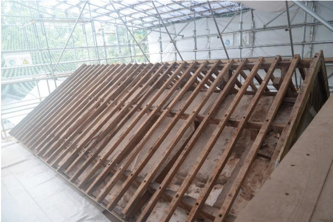
③ 置屋根野地板解体完了。小屋組状況
