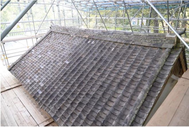
① 修理前瓦屋根
