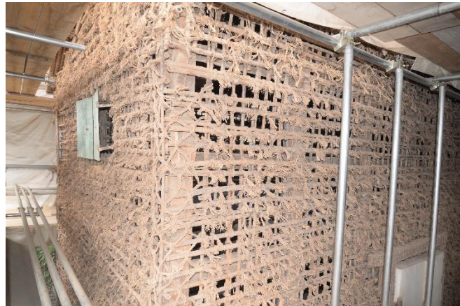
⑦ 壁土解体完了。小舞状況。
