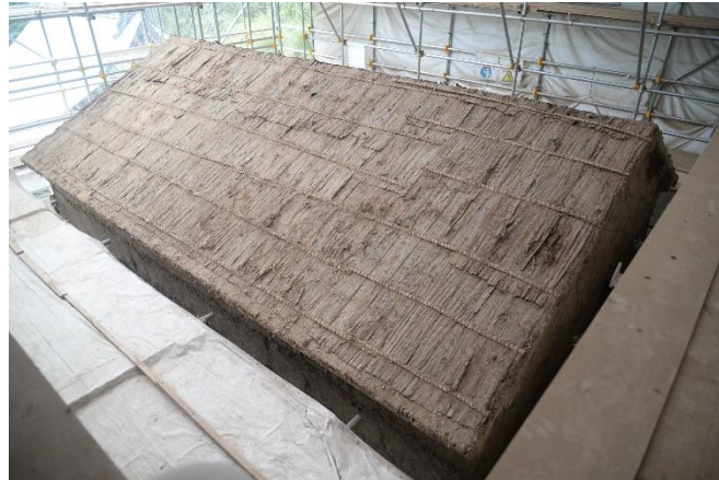
⑤ 土屋根野地状況
