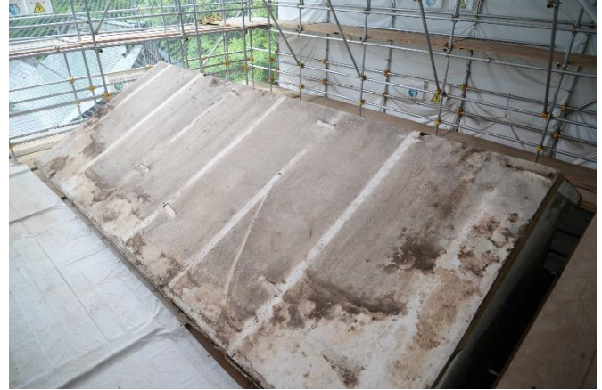
④ 置屋根解体完了。土屋根状況、漆喰仕上げ。
