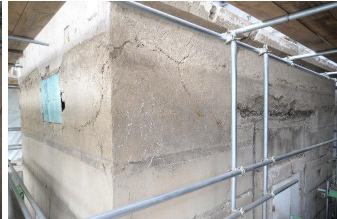
⑥ 外部腰壁、漆喰解体完了
