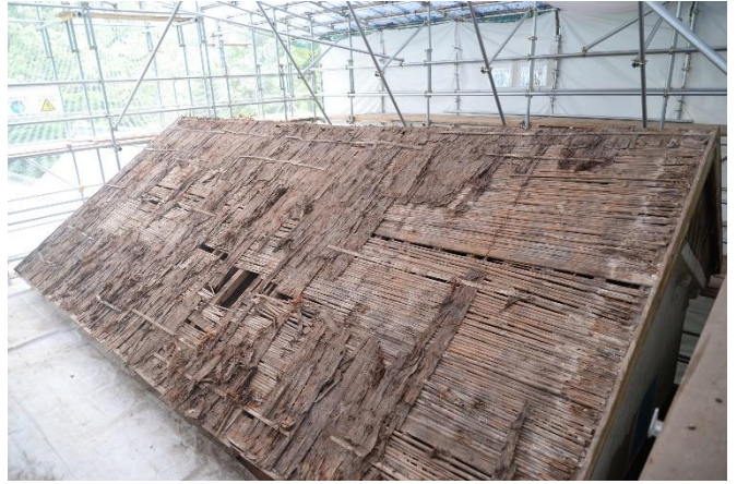
② 瓦、葺き土解体完了。野地状況。
