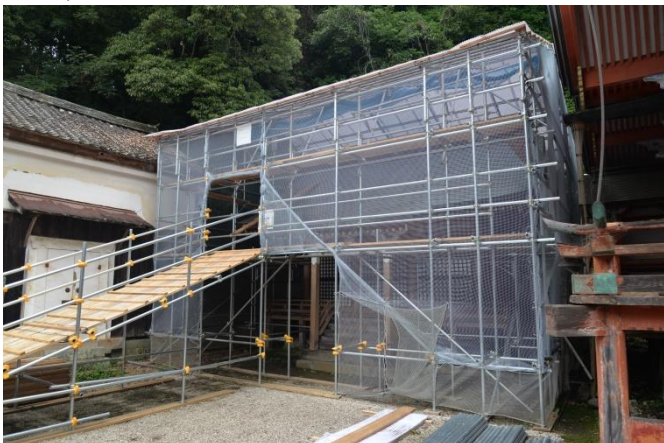
① 素屋根設置
