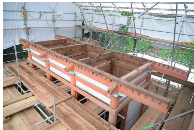
⑥ 化粧軒解体完了
