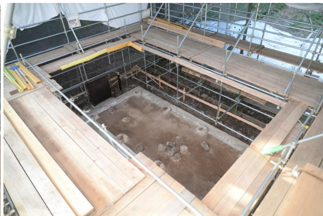
⑧ 木部解体完了
