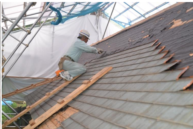
② 屋根銅板解体中
