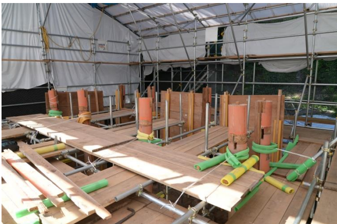
⑦ 軸組解体中
