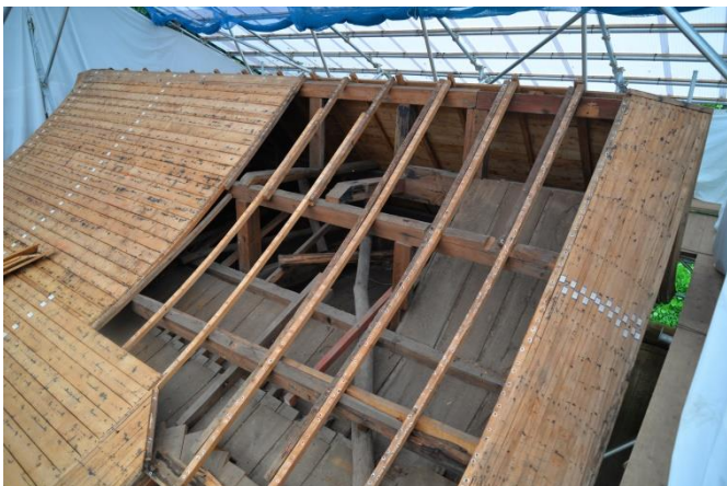
③ 野地板解体中
