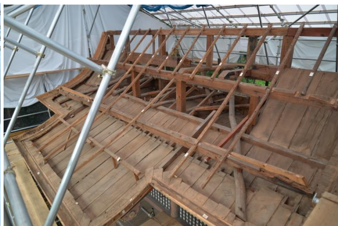
④ 小屋組状況
