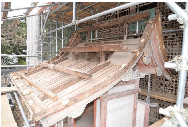
① 野地解体完了
