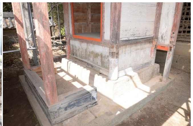
② 縁廻解体完了
