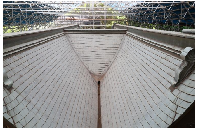
図6 修理前屋根東から見る。(左が前殿、右が後殿)
