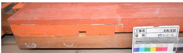
図10 桁下面（当初の丹塗が残る）
