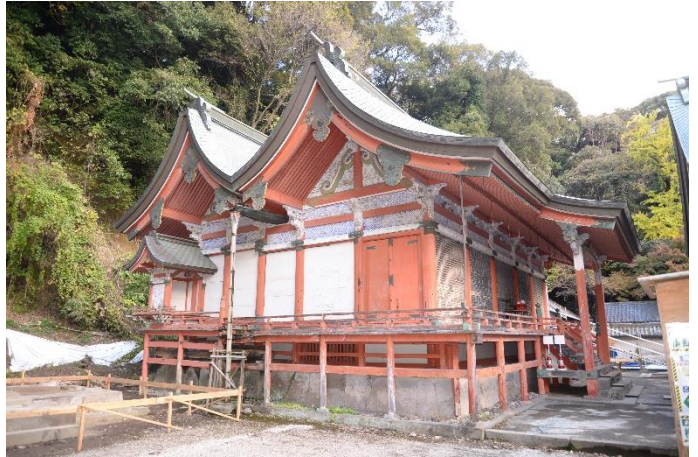
図1 修理前南西面
